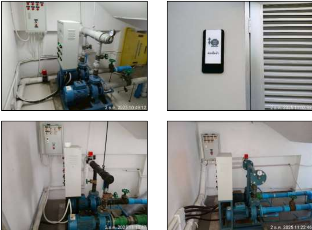
รูปที่ 1-5 ปั้มน้ำสำหรับถังเก็บน้ำชั้นใต้ดิน
